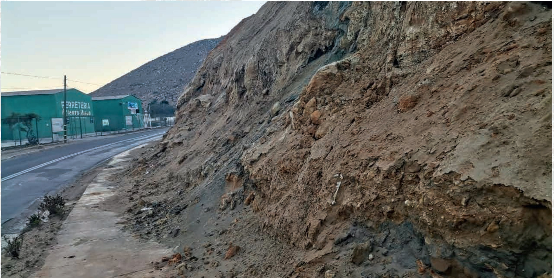
Relave ubicado en la entrada de la ciudad de Illapel, Región de Coquimbo.
